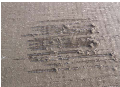
Aletas del aire acondicionado obstruidas y sucias
